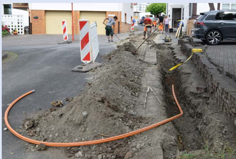
Das Glasfaserkabel wird 30 Zentimeter tief in die Erde gelegt. Die Verlegearbeiten kommen gut voran, hier in der Freiheit. Foto: Uwe Dittmer
