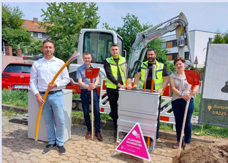
Der Glasfaserausbau der Telekom in Homberg hat begonnen. Beim symbolischen Spatenstich mit Glasfaserkabel und Verteilerkasten trafen sich, v.li.: Andreas Schade, Technischer Projektleiter, Holger König, Regio-Manager Infrastrukturvertrieb, Berkay Ince und Geschäftsführer Erdal Ince von EM Bau GmbH und die Erste Stadträtin Claudia Ulrich. Foto: Uwe Dittmer
